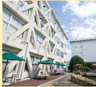
耐震補強された校舎
