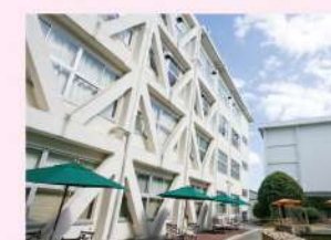
耐震補強された校舎
