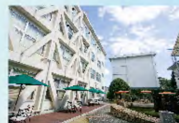
耐震補強された学舎
