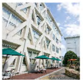
耐震化された校舎
